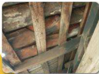
Tejas colocadas sobre las reglas de madera
